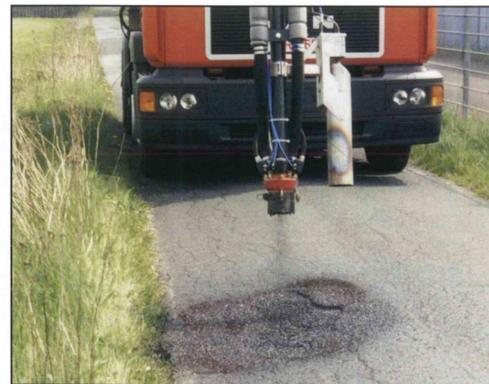
In der Düse wird der Edelsplitt und das bituminöse Bindemittel zu einer stabilen und homogenen Masse vermischt.
